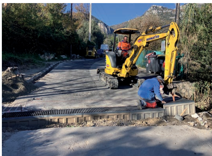
Intervention sur un caniveau chemin des Vergers suite aux intempéries d'octobre dernier.
