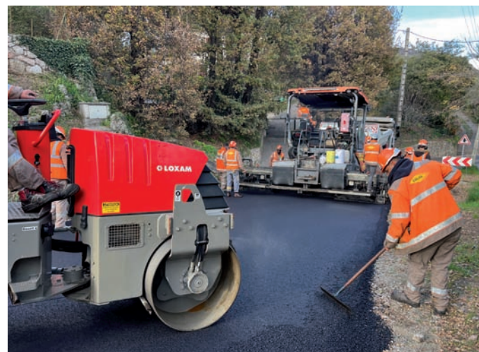
Enrobé chemin de L'Escuré
