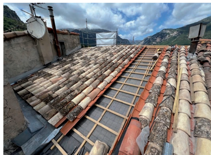
Rénovation d'une toiture en péril
