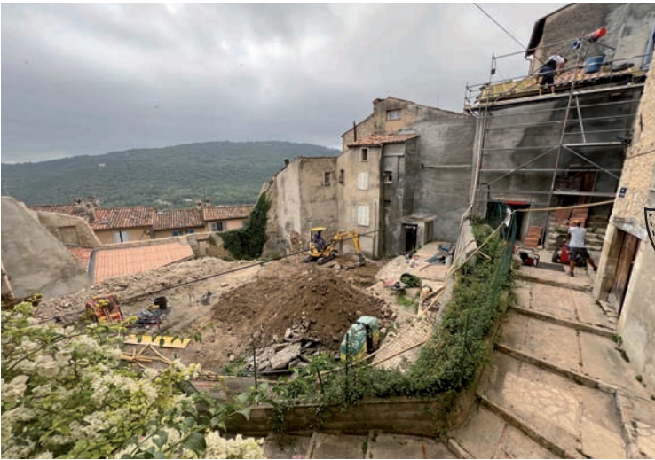
Pendant les travaux
