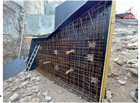
Mise en place d'un mur de soutènement (voile de béton ancré)
