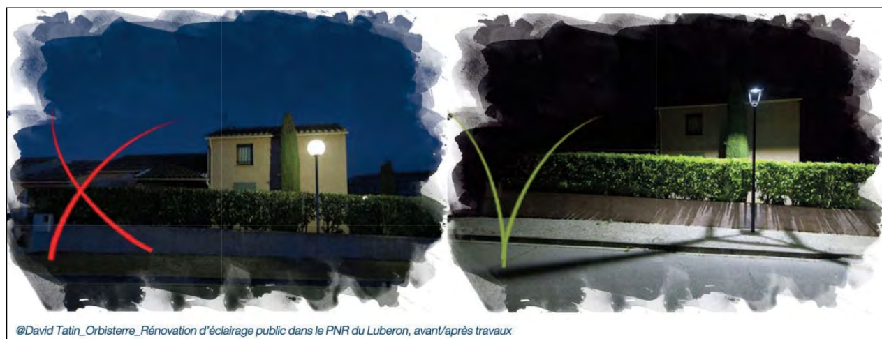
Figure 32 : Exemple d'éclairage avant et après travaux dans le PNR du Lubéron (second niveau bien moins impacté)
