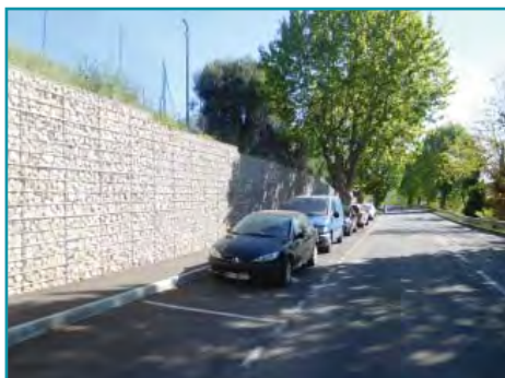
Stationnements le long de la RD 2210
