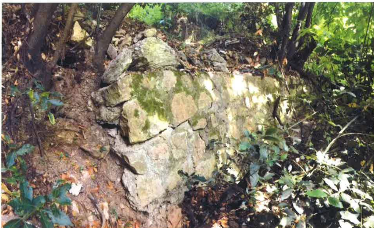
Mur pieds de talus
